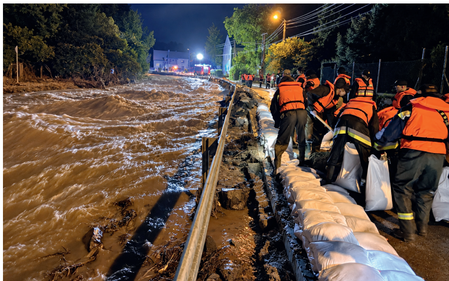
Rys. 3. Umacnianie istniejących wałów przeciwpowodziowych w trakcie powodzi w 2024 r.
