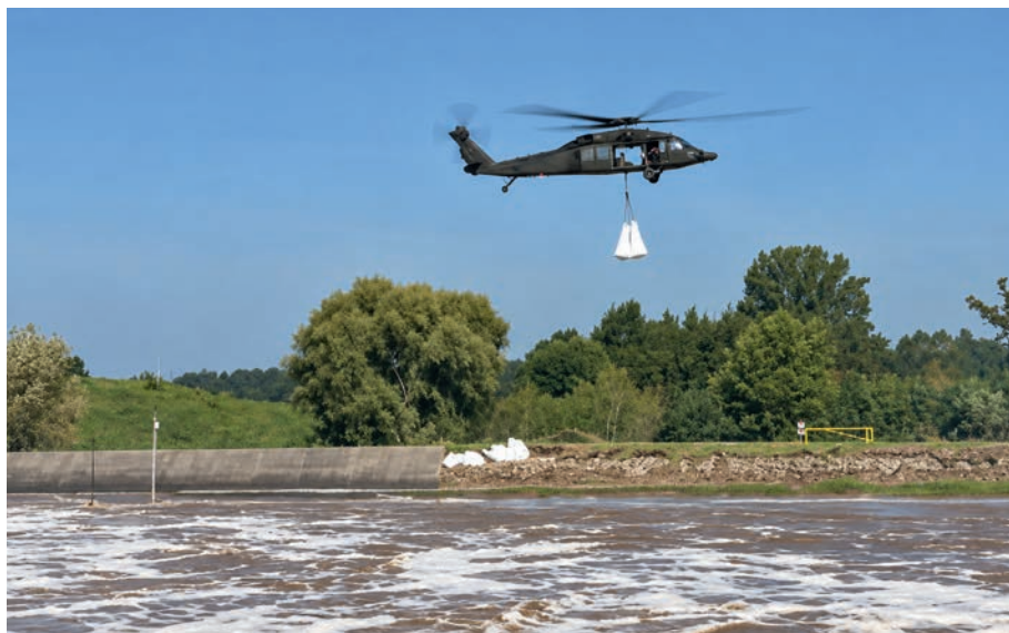
Rys. 6. Śmigłowiec w trakcie zrzutu worków typu Big-Bag z piaskiem i gruzem.
